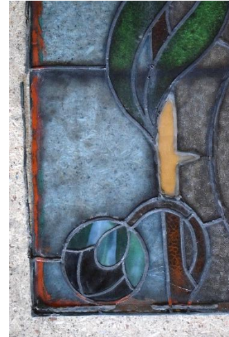
Il. 194. Fragment kwatery trzeciego okna półpiętra w kamienicy przy ul. Poniatowskiego 1. Widoczny flek z pleksi pomalowany farbą olejną i wstawiony na silikon do kwatery (Fot. Adam Kaźmierczak).
