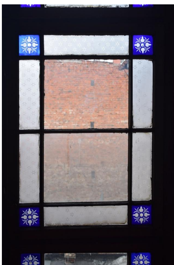
Il. 86. Toruń, ul. Sukiennicza 4. Okna trzeciego półpiętra klatki schodowej zdobione szklami muślinowymi z motywem rozetek gwiazdkowych i szlifowanymi kobaltowymi rozetkami (Fot. Adam Kaźmierczak).
