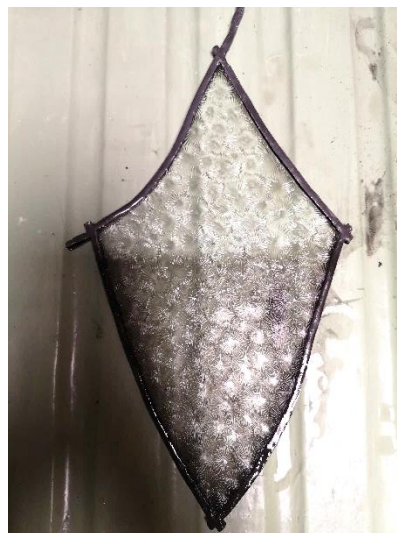
Il. 278. Fragmenty kwatery witrażowej I 2b z kamienicy przy ul. Poniatowskiego 1 w trakcie oczyszczania (Fot. Adam Kaźmierczak).
