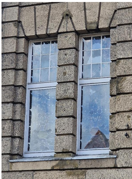
Il. 220. Szklenie ochronne bezpośrednio stykające się z witrażami okien klatki schodowej w budynku przy Placu Rapackiego 1 (Fot. Adam Kaźmierczak).
