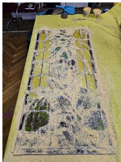
Il. 363. Czyszczenie trocinami po kitowaniu witraży z budynku przy Placu Rapackiego 1 (Fot. Adam Kaźmierczak).
