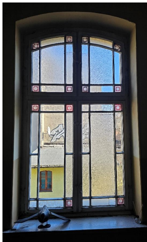
Il. 83. Toruń, ul. Sienkiewicza 22. Okna klatki schodowej zdobione trawionymi motywami winnej latorośli i piaskowanymi rozetkami (Fot. Adam Kaźmierczak).
