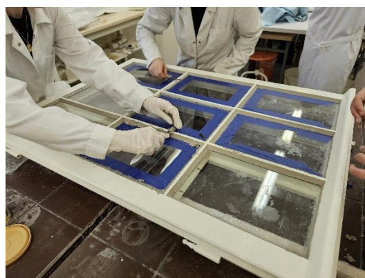
Il. 389. Montaż szklenia ochronnego na kit szklarski z budynku przy Placu Rapackiego 1 (Fot. Adam Kaźmierczak).
