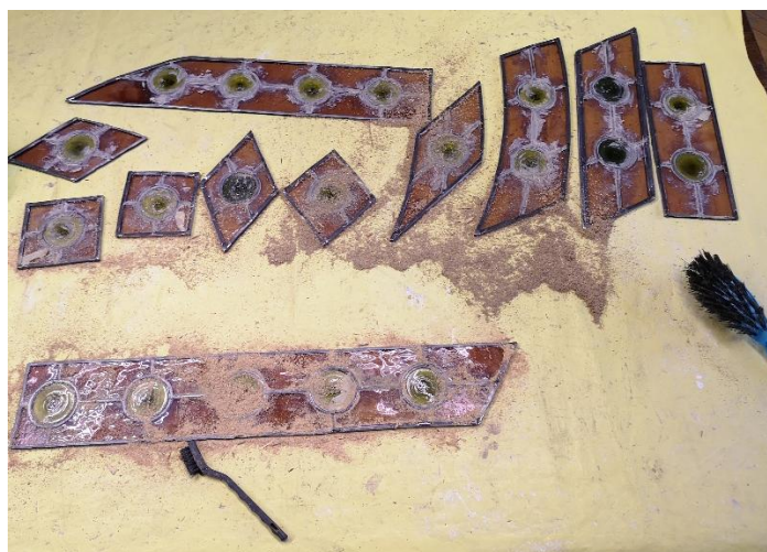
Il. 361. Kitowanie kwater witraży gomółkowych z kamienicy przy ul. Jagiellończyka 6 (Fot. Adam Kaźmierczak).
