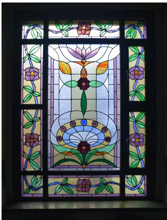
Il. 119. Toruń, ul. Poniatowskiego 3. Secesyjne witraże okien pierwszego i drugiego półpiętra klatki schodowej po częściowej rekonstrukcji (Fot. Adam Kaźmierczak).
