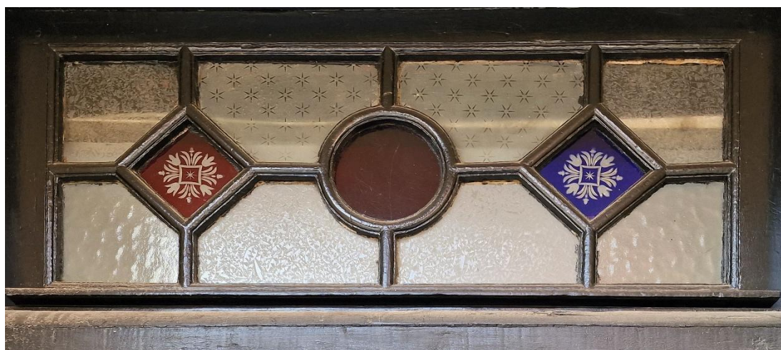
Il. 76. Szlifowane rozetki w nadświetlu drzwi wejściowych do kamienicy przy Rynku Nowomiejskim 17 w Toruniu: rubinowa i kobaltowa. W górnych narożnikach oraz w dwóch dolnych polach znajduje się szkło mrożone (Fot. Adam Kaźmierczak).
