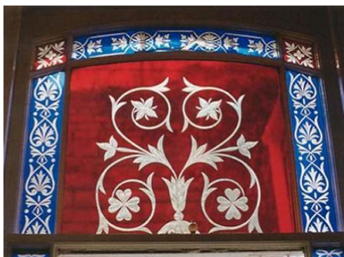
Il. 21. Przykład szlifów brylantowych na szklach powlekanych. Za: Stawiarski, „Zdobienie szkła”.
