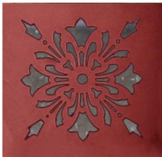
Il. 80. Nieistniejąca już piaskowana rozetka na rubinowym szkłe powłokowym w drzwiach sieni w kamienicy przy ul. Mickiewicza 57 (Fot. Adam Kaźmierczak).
