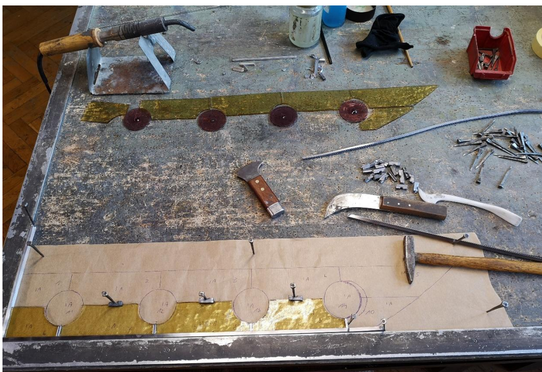
Il. 354. Rekonstrukcja bordiury gomółkowej witraży z kamienicy przy ul. Jagiellończyka 6 (Fot. Adam Kaźmierczak).
