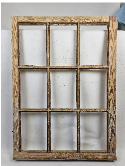
Il. 374. Jedno ze skrzydeł okiennych z budynku przy Placu Rapackiego 1 po usunięciu przemaalowań i uzupełnieniu ubytków drewna (Fot. Adam Kaźmierczak).
