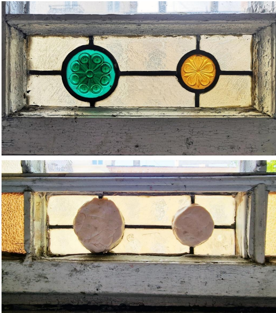
Il. 338. Etapy odtwarzania szmaragdowej i żółtej rozetki, od góry: rozetki znajdujące się w kwaterze okna; gęsty silikon dentystyczny nałożony na szklane detale (Fot. Adam Kaźmierczak).
