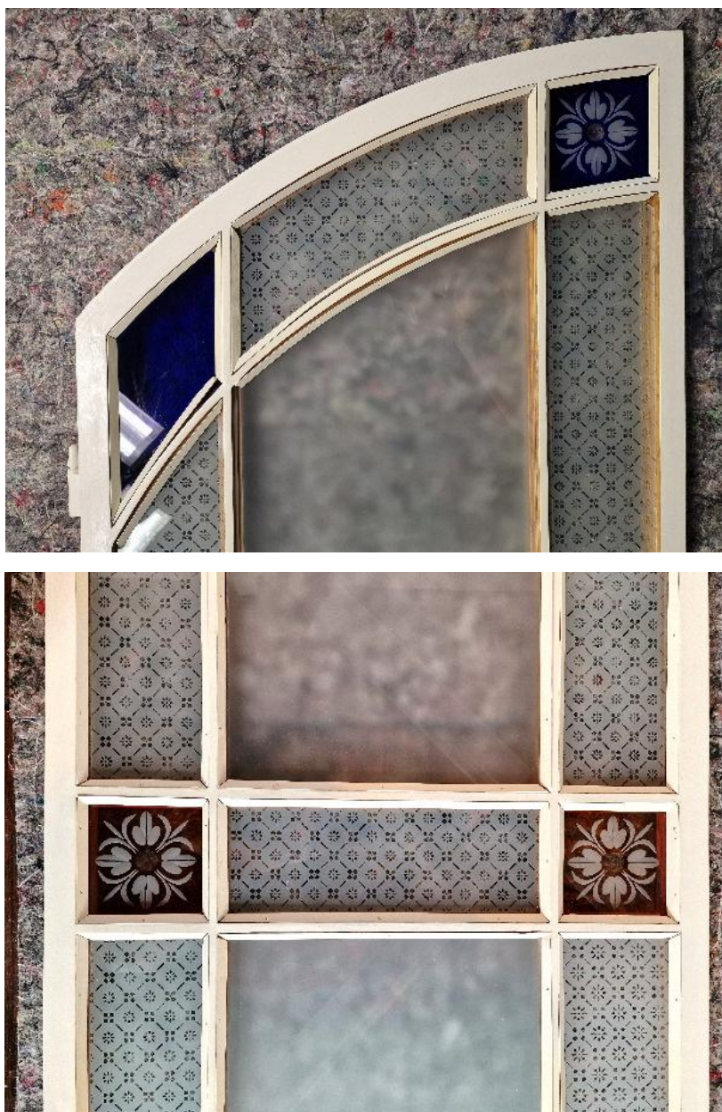
Il. 385. Montaż oszklenia ozdobnego na drewniane listewki z kamienicy przy ul. Jagiellończyka 4 (Fot. Adam Kaźmierczak).
