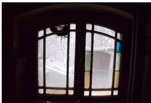
Il. 176. Silnie zabrudzone i z licznymi ubytkami szkła okna klatki schodowej w kamienicy przy ul. Szerokiej 26-28 (Fot. Adam Kaźmierczak).
