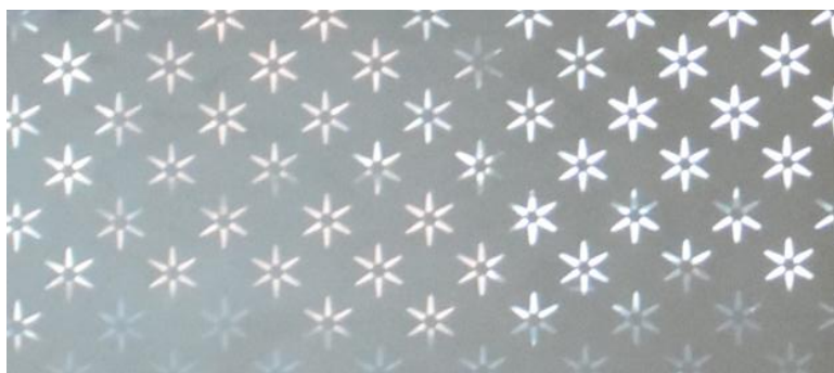
Il. 68. Przykład szkła muślinowego z motywem gwiazdkowym w drzwiach do mieszkania kamienicy przy ul. Warszawskiej 2 w Toruniu (Fot. Adam Kaźmierczak).
