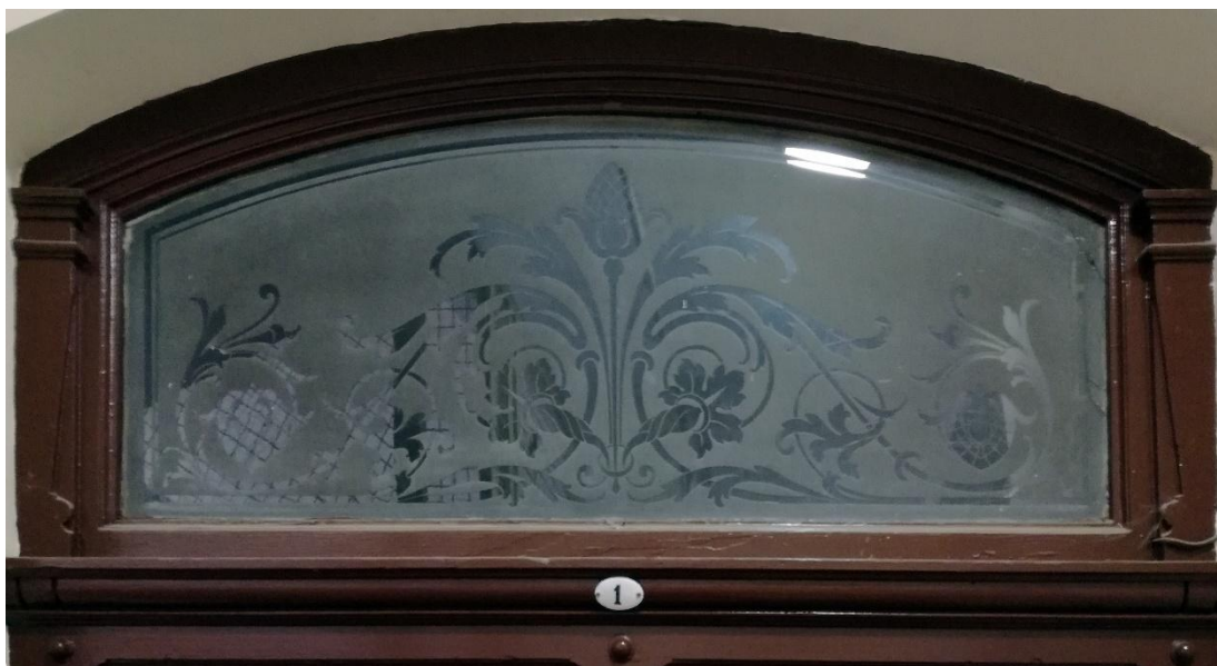
Il. 98. Toruń, ul. Łazienna 7. Nadświetle drzwi wejściowych do mieszkania zdobione trawionym ornamentem na matowym tle (Fot. Adam Kaźmierczak).
