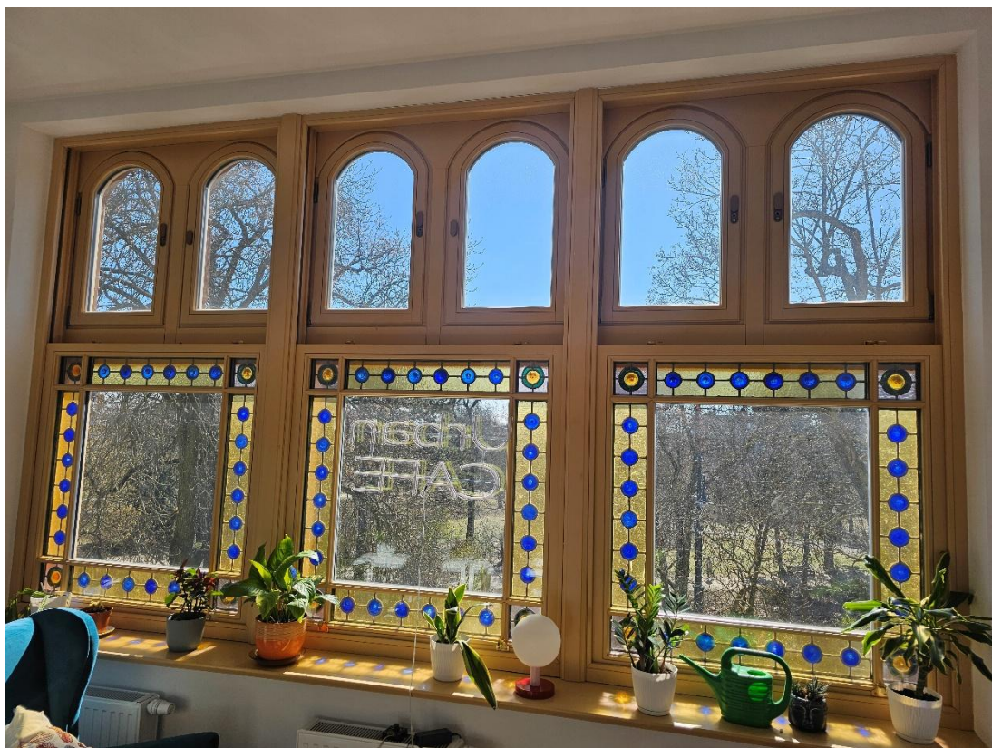
Il. 115. Toruń, ul. Bydgoska 50-52. Przykład okna drugiego piętra z bordiurą gomółkową (Fot. Adam Kaźmierczak).
