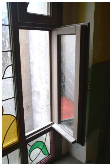
Il. 247. Sposób zamontowania witraży po konserwacji na styk z nowym oszkleniem w nowej stolarce okiennej w kamienicy przy ul. Poniatowskiego 3 (Fot. Adam Kaźmierczak).
