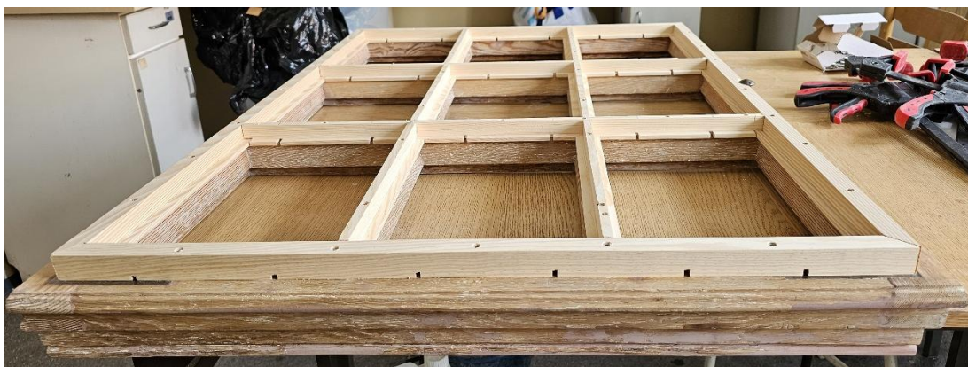
Il. 381. Skrzydło okienne 2b po zamontowaniu nowych ramek dla witraży z budynku przy Placu Rapackiego 1. Widoczne otwory wentylacyjne na poziomych listwach (Fot. Adam Kaźmierczak).
