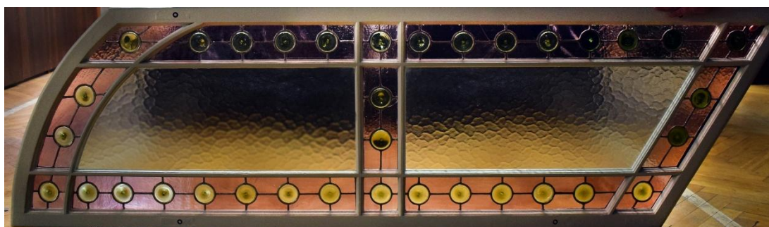
Il. 328. Zestawienie oryginalnego szkła ornamentowego o wypukłych krakelurach (po prawej) z odtworzoną fakturą ze szkła typu Float (po lewej). Skrzydło okienne kamienicy przy ul. Jagiellończyka 6 w trakcie oszklenia po pracach konserwatorskich i restauratorskich (Fot Adam Kaźmierczak).
