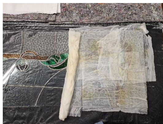
Il. 276. Okłady z ligniny nasączonej 6% fosforanem trójsodowym dwunastowodnym. Po prawej widoczne przebarwienia ligniny świadczące o rozpuszczeniu zabrudzeń. Witraże z kamienicy przy ul. Poniatowskiego 1 (Fot. Adam Kaźmierczak).
