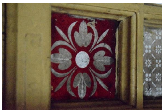
Il. 209. Oszklenia ozdobne klatki schodowej w kamienicy przy ul. Jagiellończyka 4. Przykłady szkła muslinowego i szlifowanej rozetki z silnymi zabrudzeniami powierzchni (Fot. Adam Kaźmierczak).
