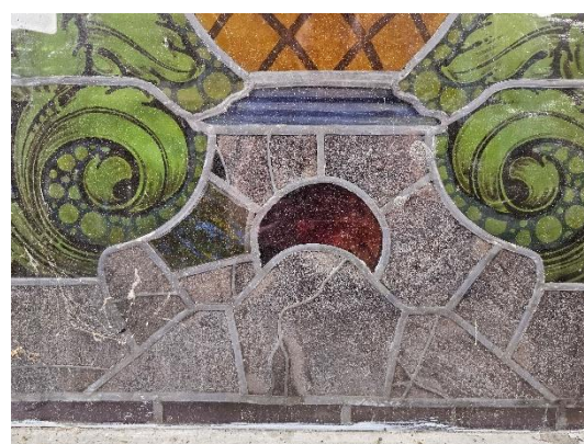
Il. 223. Fragment dolnej kwatery 1a z widocznymi nawarstwieniami korozyjnymi szkła mąconych (Fot. Adam Kaźmierczak).
