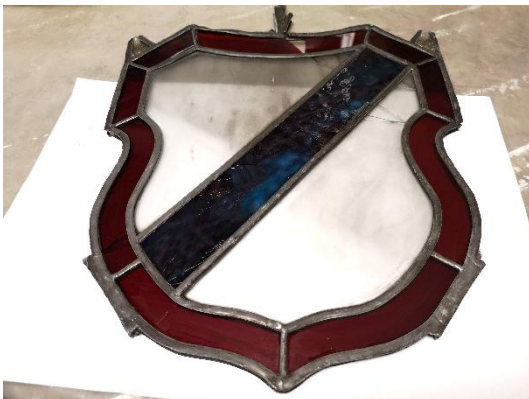
Il. 278. Fragmenty kwatery witrażowej I 2b z kamienicy przy ul. Poniatowskiego 1 w trakcie oczyszczania (Fot. Adam Kaźmierczak).
