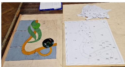
Il. 314. Wycinanie szkieł do rekonstruowanej kwatery witrażowej III1a z kamienicy przy ul. Poniatowskiego 1 (Fot. Adam Kaźmierczak).
