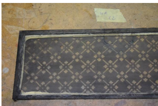
Il. 209. Oszklenia ozdobne klatki schodowej w kamienicy przy ul. Jagiellończyka 4. Przykłady szkła muslinowego i szlifowanej rozetki z silnymi zabrudzeniami powierzchni (Fot. Adam Kaźmierczak).
