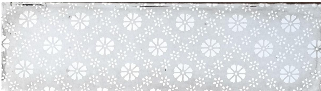
Il. 67. Przykład szkła muślinowego z okna klatki schodowej kamienicy przy ul. Klonowica 24 w Toruniu (Fot. Adam Kaźmierczak).
