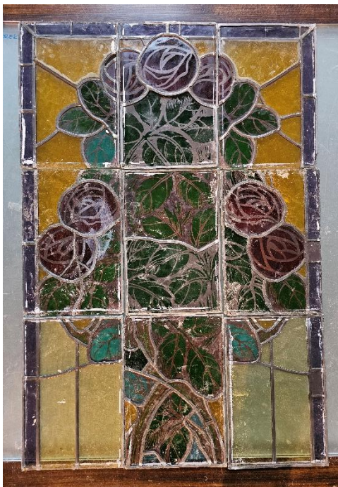
Il. 229. Witraże skrzydła 2a (awers) okna klatki schodowej w budynku przy Placu Rapackiego 1. Widoczne uszkodzenia i zabrudzenia powierzchni (Fot. Adam Kaźmierczak).
