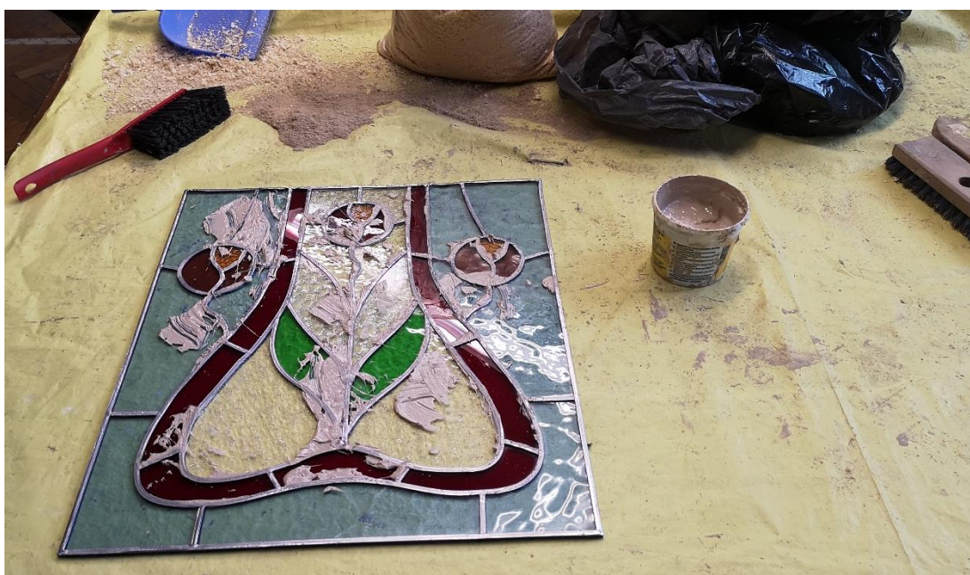
Il. 359. Kitowanie kwatery IIIa witraży z kamienicy przy ul. Poniatowskiego 1 (Fot. Adam Kaźmierczak).
