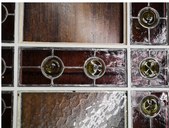
Il. 382. Montaż kwater witrażowych i szkieł w ramy okienne z kamienicy przy ul. Jagiellończyka 6 (Fot. Adam Kaźmierczak).
