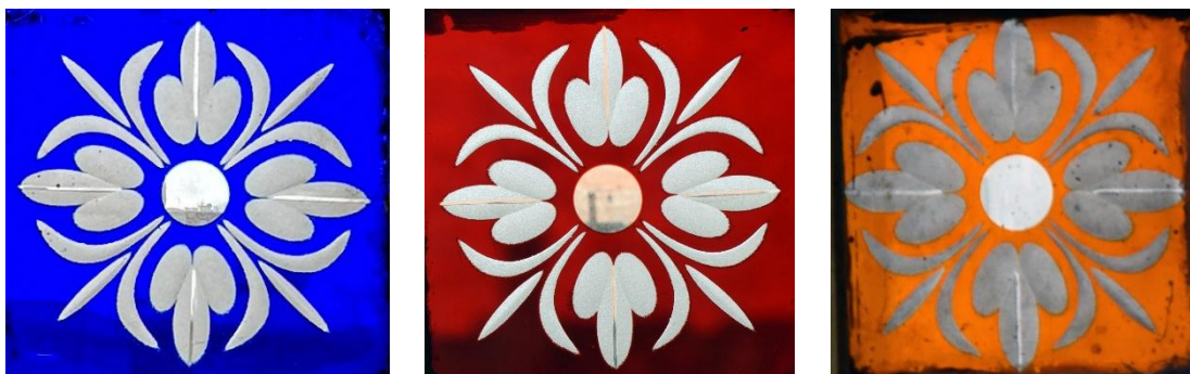
Il. 75. Przykładowe szlifowane i częściowo polerowane rozety na szkłe powłokowym: kobaltowym, rubinowym i oranżowym. Od lewej: ul. Klonowica 24, ul. Sukiennicza 4, ul. Jagiellończyka 4 w Toruniu (Fot. Adam Kaźmierczak).
