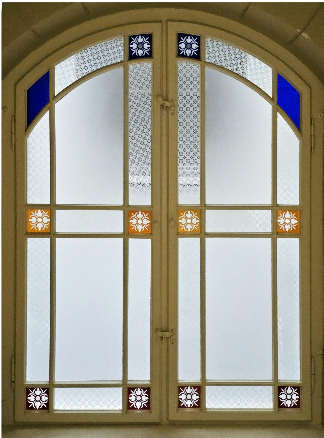
Il. 395. Oszklenie ozdobne okna II półpiętra klatki schodowej kamienicy przy ul. Jagiellończyka 4 po pracach konserwatorskich i restauratorskich (Fot. Adam Kaźmierczak).
