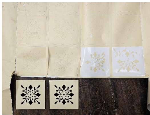
Il. 323. Po lewej rubinowe i kobaltowe szkło powłokowe, po prawej przyklejanie folii z wyciętymi wzorami rozetek (Fot. Adam Kaźmierczak).
