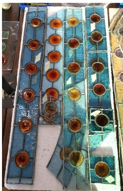
Il. 291. Wybrane kwatery witrażowe z kamienicy przy ul. Jagiellończyka 6 po oczyszczeniu (Fot. Adam Kaźmierczak).
