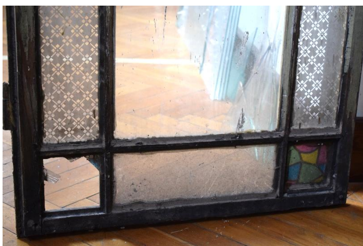
Il. 200. Dolna część skrzydła okiennego trzeciego półpiętra klatki schodowej w kamienicy przy ul. Jagiellończyka 4. Widoczne wtórne uzupełnienia pól szklami okiennymi, narożne z przyklejoną kolorową folią, lewe stłuczone (Fot. Adam Kaźmierczak).
