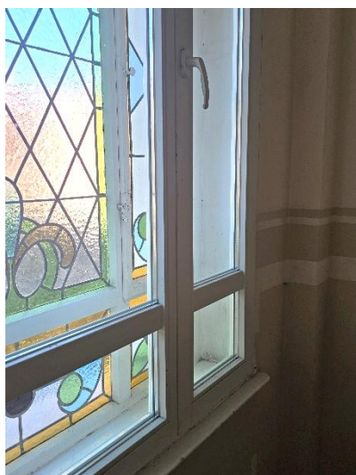
Il. 251. Oszklenie termoizolacyjne zamontowane w nowym oknie po stronie wewnętrznej klatki schodowej w kamienicy przy ul. Mickiewicza 52 (Fot. Adam Kaźmierczak).
