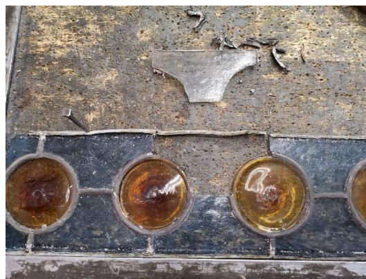
Il. 265. Usuwanie wtórnego szkła jednej z kwater witrażowych trzeciego okna kamienicy przy ul. Jagiellończyka 6 (Fot. Adam Kaźmierczak).
