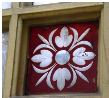
Il. 22. Przykład szlifowanego dekoru na rubinowym szkłe powłokowym z okna klatki schodowej przy ul. Jagiellończyka 4 w Toruniu. (Fot. Adam Kaźmierczak).
