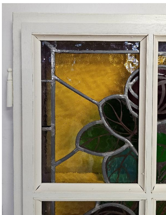
Il. 392. Fragment skrzydła okiennego po zamontowaniu witraży na drewniane listewki z budynku przy Placu Rapackiego 1 (Fot. Adam Kaźmierczak).
