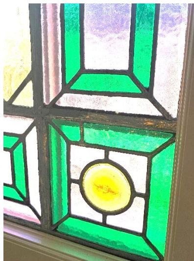
Il. 250. Sposób zamontowania witraży po konserwacji po stronie wewnętrznej w nowej stolarce okiennej w willi przy ul. Bydgoskiej 50-52. Listwy ołowiane wtórnie naśladują podziały drewnianych szprosów (Fot. Adam Kaźmierczak).
