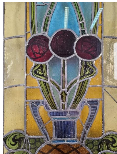
Il. 221. Fragmenty dolnej kwatery 1a z widocznymi uzupełnieniami szkła oraz łączeniami pęknięć szkła cienkimi listwami ołowianymi (Fot. Adam Kaźmierczak).
