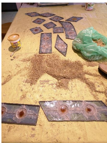
Il. 361. Kitowanie kwater witraży gomółkowych z kamienicy przy ul. Jagiellończyka 6 (Fot. Adam Kaźmierczak).
