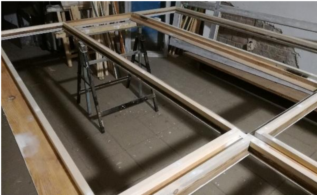
Il. 376. Montaż nowych ramek dla witraży po pracach konserwatorskich i restauratorskich Z kamienicy przy ul. Poniatowskiego 1 (Fot. Malwina Lewandowicz).
