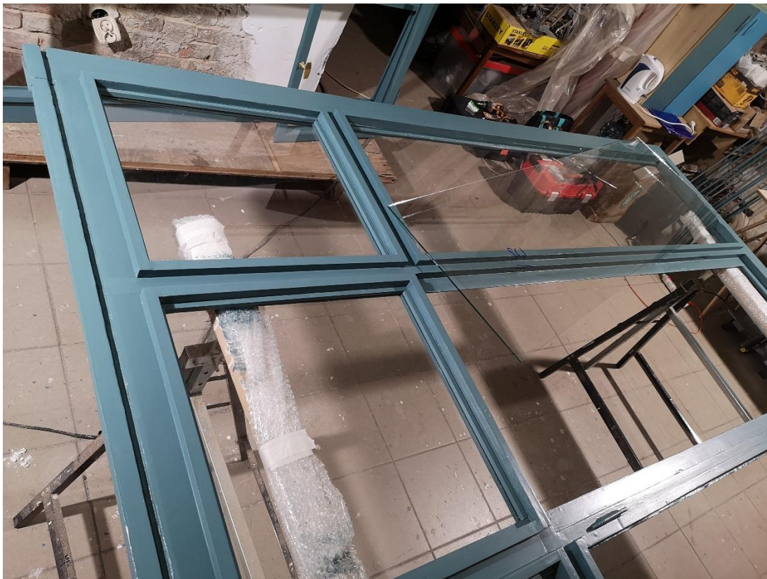
Il. 377. Montaż oszklenia ochronnego w ramy okna z kamienicy przy ul. Poniatowskiego 1 (Fot. Adam Kaźmierczak).
