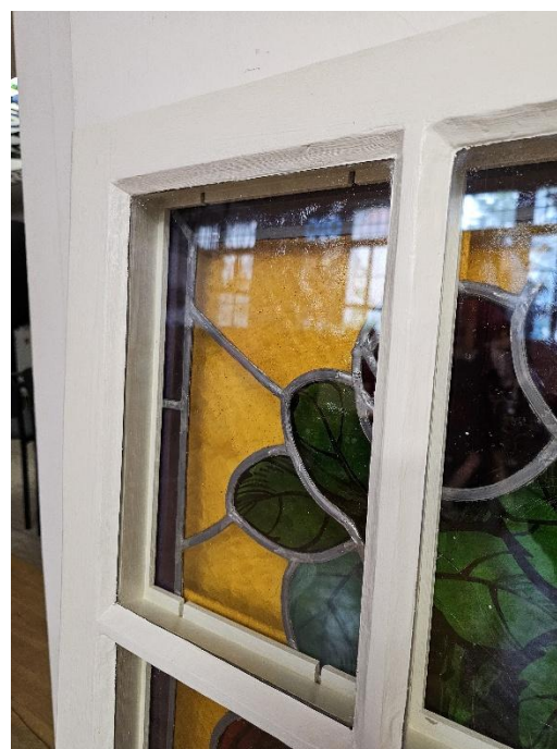
Il. 393. Fragment skrzydła okiennego po zamontowaniu witraży i z widocznym opracowanym kitem szklarskim oszklenia ochronnego po stronie zewnętrznej z budynku przy Placu Rapackiego 1 (Fot. Adam Kaźmierczak).
