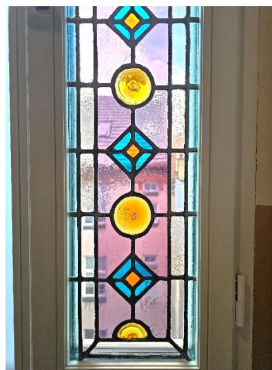
Il. 248. Sposób zamontowania witraży po konserwacji na styk z nowym oszkleniem w nowej stolarce okiennej w kamienicy przy ul. Piastowskiej 5 (Fot. Adam Kaźmierczak).
