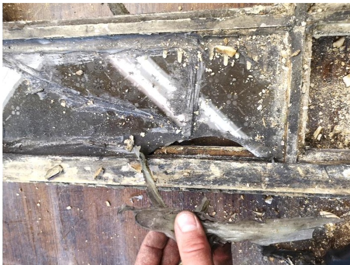
Il. 270. Usuwanie silikonu ze szkła i uzupełnień kitu szklarskiego. Okna z kamienicy przy ul. Jagiellończyka 4 (Fot. Adam Kaźmierczak).
