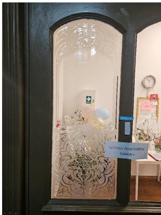
Il. 117. Toruń, ul. Bydgoska 50-52. Zachowany trawiony ornament w płycinie drzwi (Fot. Adam Kaźmierczak).
