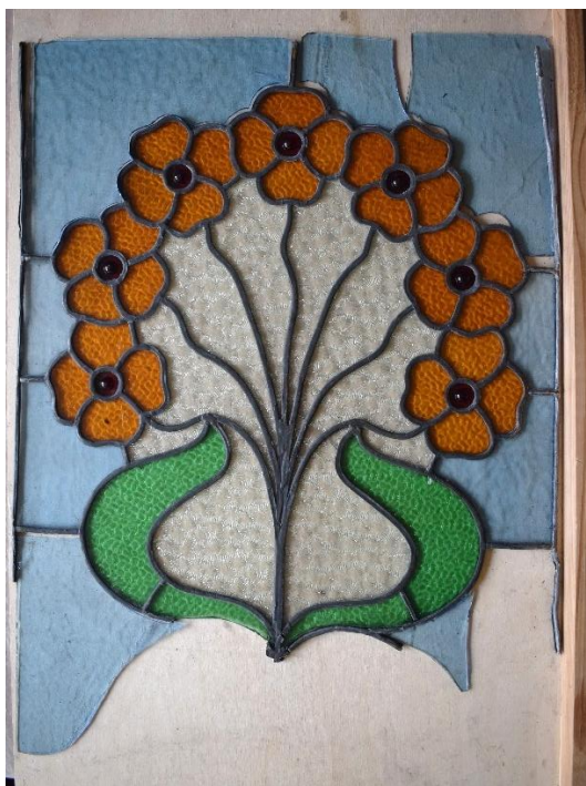
Il. 286. Fragmenty kwatery witrażowej I2a z kamienicy przy ul. Poniatowskiego 1 po oczyszczeniu (Fot. Adam Kaźmierczak).
