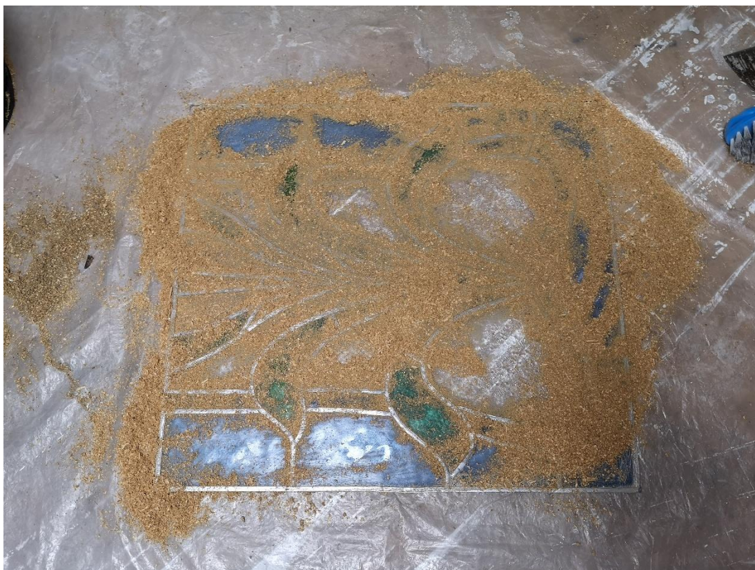
Il. 360. Czyszczenie kwatery IIa trocinami po kitowaniu. Witraże z kamienicy przy ul. Poniatowskiego 1 (Fot. Adam Kaźmierczak).
