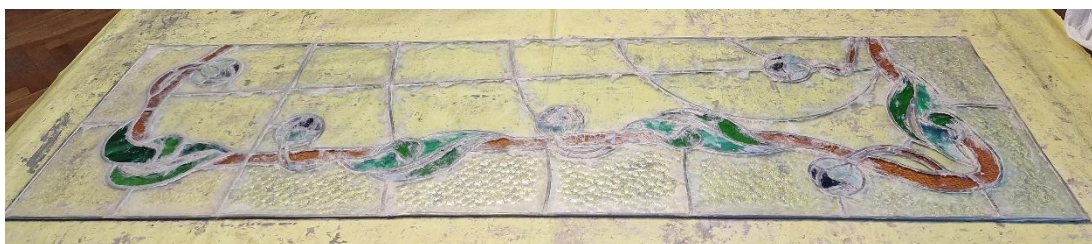
Il. 358. Kitowanie kwatery IV2a witraży z kamienicy przy ul. Poniatowskiego 1 (Fot. Adam Kaźmierczak).
