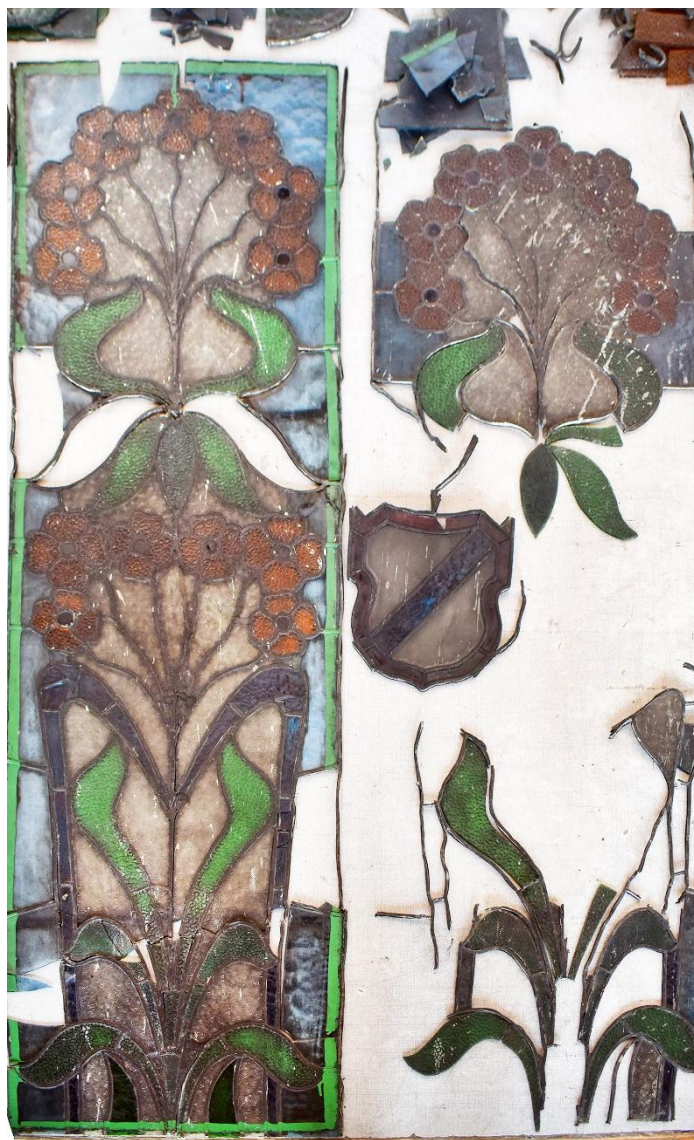
Il. 125. Toruń, ul. Poniatowskiego 1. Znalezione fragmenty secesyjnych witraży z okien pierwszego półpiętra klatki schodowej kamienicy po dopasowaniu poszczególnych elementów kompozycji (Fot. Adam Kaźmierczak).
