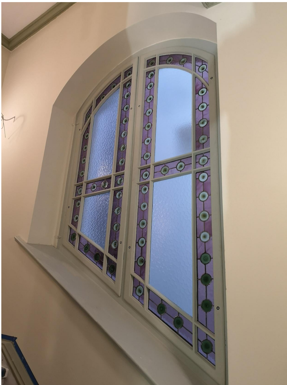
Il. 399. Witraże i oszklenia dekoracyjne okna II półpiętra klatki schodowej kamienicy przy ul. Jagiellończyka 6 po pracach konserwatorskich i restauratorskich (Fot. Adam Kaźmierczak).
