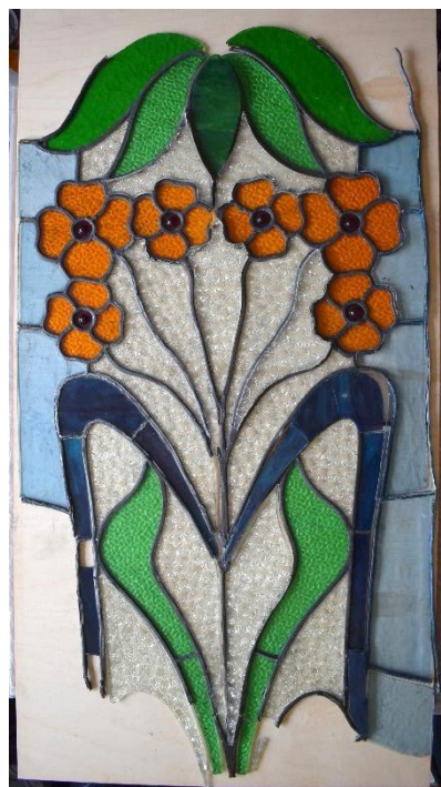
Il. 286. Fragmenty kwatery witrażowej I2a z kamienicy przy ul. Poniatowskiego 1 po oczyszczeniu (Fot. Adam Kaźmierczak).
