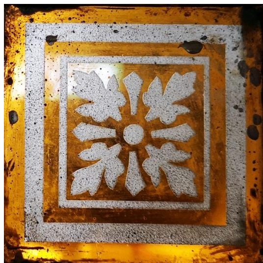
Il. 78. Przykłady piaskowanych rosetek na szkłe powłokowym kobaltowym i oranżowym z okna klatki schodowej (po lewej) oraz drzwi wahadłowych sieni (po prawej) kamienicy przy ul. Sienkiewicza 22 w Toruniu (Fot. Adam Kaźmierczak).
