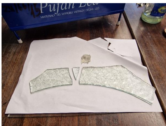
Il. 293. Klejenie szkła ornamentowego z kamienicy przy ul. Poniatowskiego 1 klejem utwardzanym światłem UV. (Fot. Adam Kaźmierczak).
