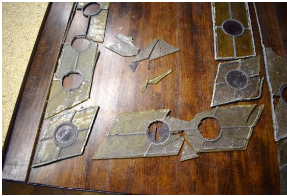
Il. 218. Kwaterki pierwszego i drugiego okna klatki schodowej w kamienicy przy ul. Jagiellończyka 6. Widoczne uszkodzenia i braki listew ołowianych, ubytki szkła oraz zabrudzenia powierzchni (Fot. Adam Kaźmierczak).
