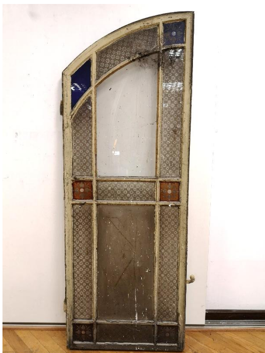
Il. 201. Skrzydło drugiego okna półpiętra klatki schodowej w kamienicy przy ul. Jagiellończyka 4. Widoczne zachowane szkło matowe dolnego głównego pola. Powierzchnia szkła i ramy jest mocno zabrudzona (Fot. Adam Kaźmierczak).
