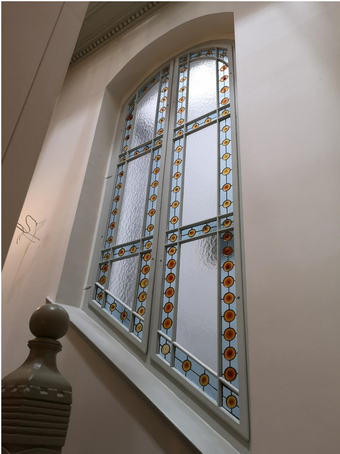
Il. 400. Witraże i oszklenia dekoracyjne okna III półpiętra klatki schodowej kamienicy przy ul. Jagiellończyka 6 po pracach konserwatorskich i restauratorskich (Fot. Adam Kaźmierczak).
