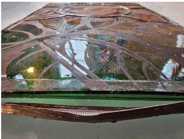
Il. 226. Kwaterka 2a/2a witrażu okna klatki schodowej w budynku przy Placu Rapackiego 1. Widoczne zdublowane szkło wtórnego uzupełnienia (Fot. Adam Kaźmierczak).
