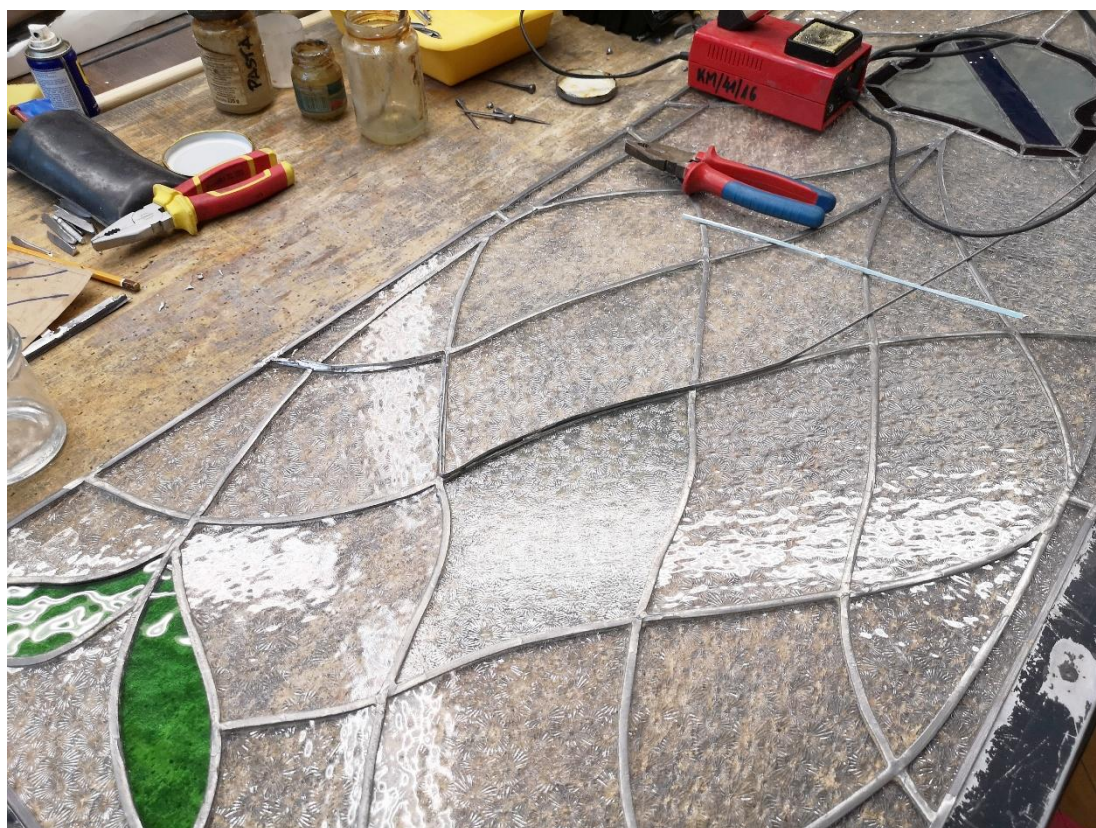
Il. 364. Przylutowywanie wiatrownic ze stali ocynkowanej do kwatery I2b witraży z kamienicy przy ul. Poniatowskiego 1 (Fot. Adam Kaźmierczak).
