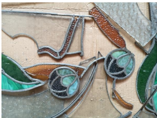
Il. 198. Fragmenty kwatery okna, która kiedyś znajdowała się w jednym z mieszkań kamienicy przy ul. Poniatowskiego 1. Widoczne uszkodzenia siatki ołowianej, pęknięcia i ubytki szkła (Fot. Adam Kaźmierczak).
