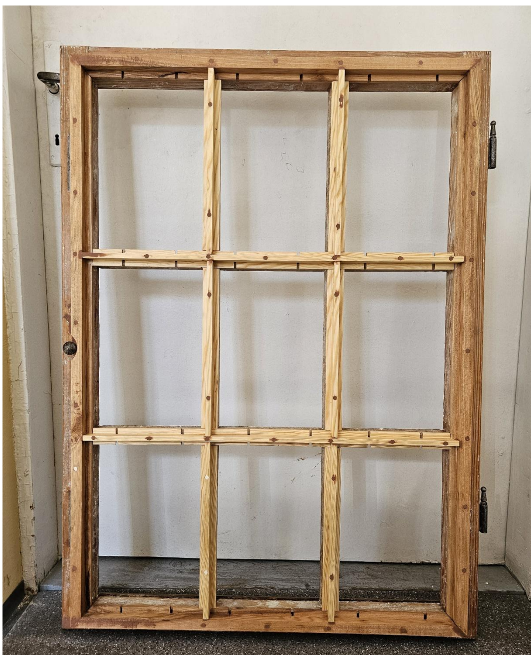
Il. 380. Skrzydło okienne 2b po zamontowaniu nowych ramek dla witraży z budynku przy Placu Rapackiego 1 (Fot. Adam Kaźmierczak).
