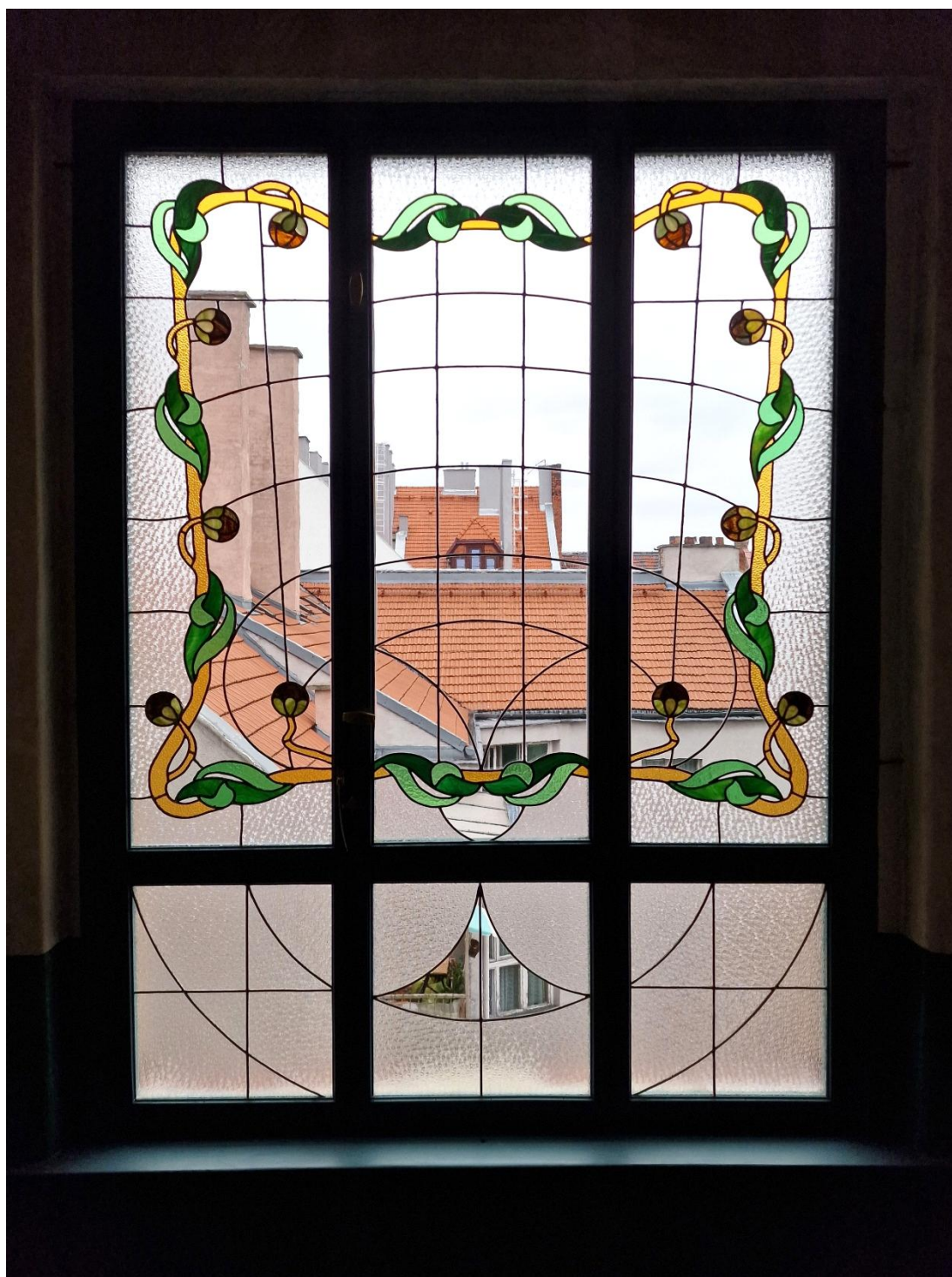
Il. 404. Witraże mozaikowe okna IV półpiętra klatki schodowej kamienicy przy ul. Poniatowskiego 1 po pracach konserwatorskich i restauratorskich (Fot. Adam Kaźmierczak).
