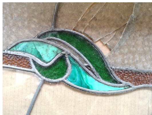
Il. 198. Fragmenty kwatery okna, która kiedyś znajdowała się w jednym z mieszkań kamienicy przy ul. Poniatowskiego 1. Widoczne uszkodzenia siatki ołowianej, pęknięcia i ubytki szkła (Fot. Adam Kaźmierczak).
