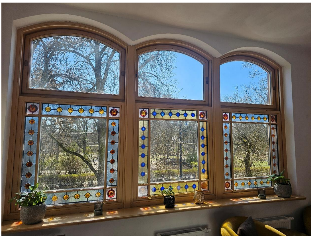
Il. 114. Toruń, ul. Bydgoska 50-52. Przykład okna pierwszego piętra z bordiurą gomółkową (Fot. Adam Kaźmierczak).
