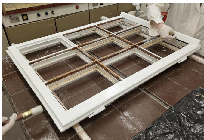
Il. 375. Jedno ze skrzydeł okiennych z budynku przy Placu Rapackiego 1 w trakcie malowania białozółtawą farbą na bazie oleju lnianego (Fot. Adam Kaźmierczak).
