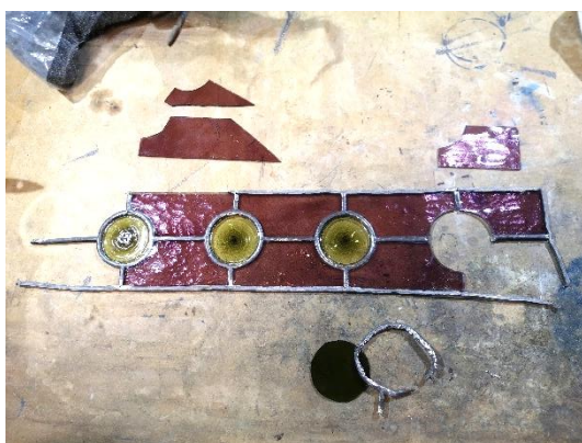
Il. 266. Usuwanie wtórnych szkielek jednej z kwater witrażowych trzeciego okna kamienicy przy ul. Jagiellończyka 6 (Fot. Adam Kaźmierczak).
