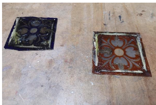
Il. 269. Usuwanie zabrudzeń z farby olejnej. Szlifowane rozetki z kamienicy przy ul. Jagiellończyka 4 (Fot. Adam Kaźmierczak).
