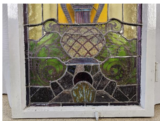
Il. 222. Fragment dolnej kwatery 1b z widocznymi uzupełnieniami szkła oraz łączenia pęknięć szkła w cienkie listwy ołowiane (Fot. Adam Kaźmierczak).
