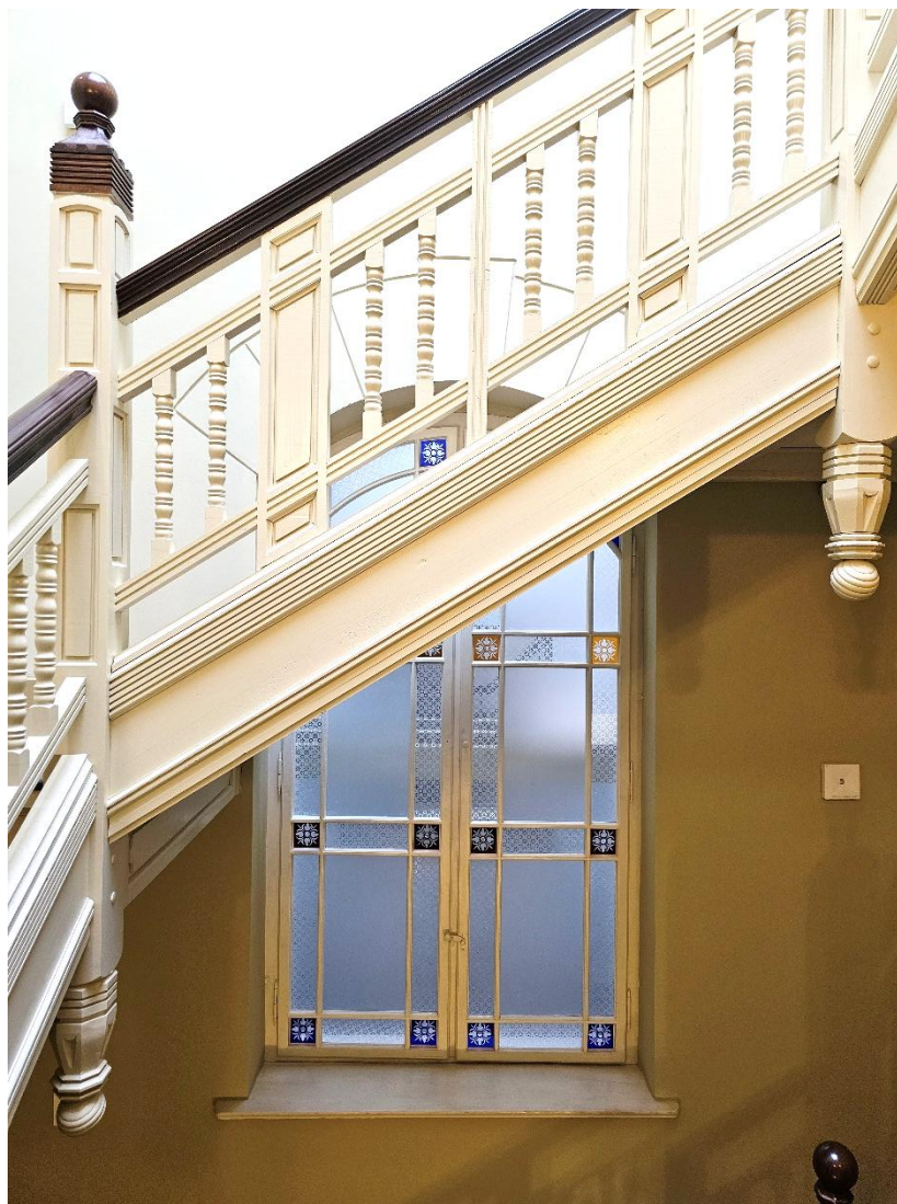
Il. 396. Oszklenie ozdobne okna IV półpiętra klatki schodowej kamienicy przy ul. Jagiellończyka 4 po pracach konserwatorskich i restauratorskich. W trakcie trwania prac nadbudowano ostatnie piętro kamienicy wstawiając dodatkowy bieg schodów (Fot. Adam Kaźmierczak).
