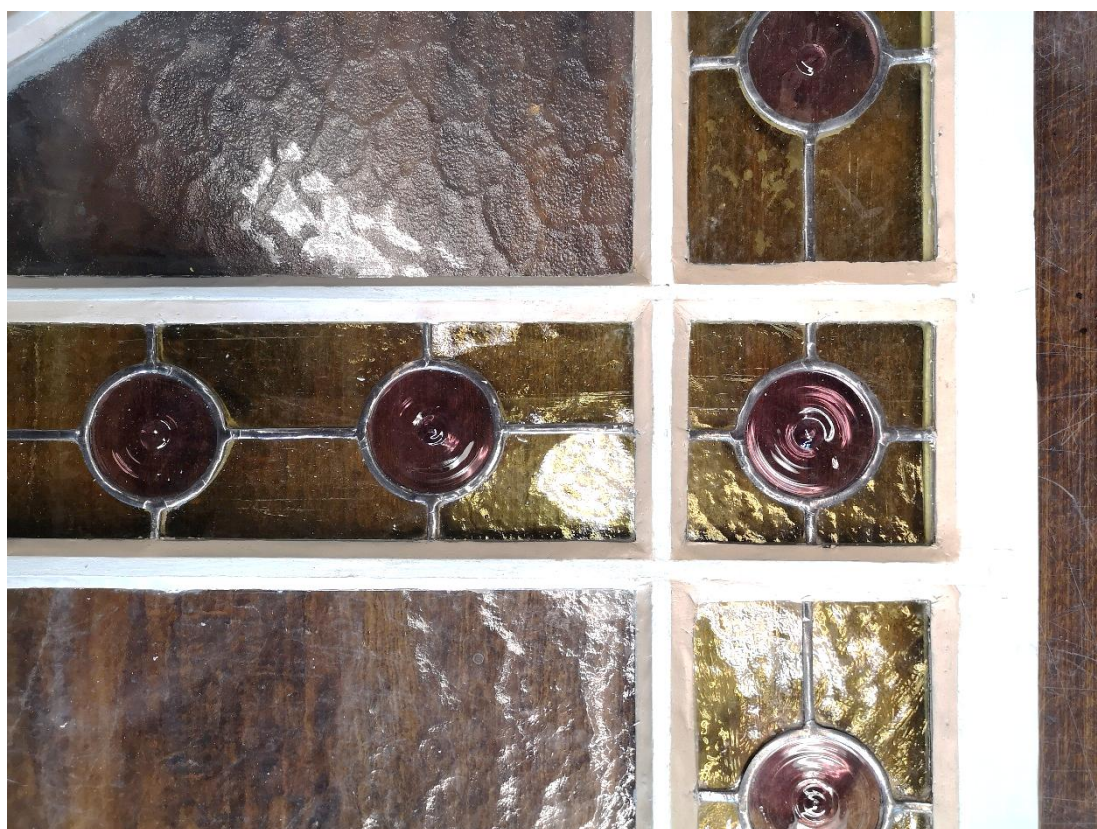
Il. 384. Opracowywanie kitu szklarskiego na oszkleniach ram okiennych z kamienicy przy ul. Jagiellończyka 6 (Fot. Adam Kaźmierczak).
