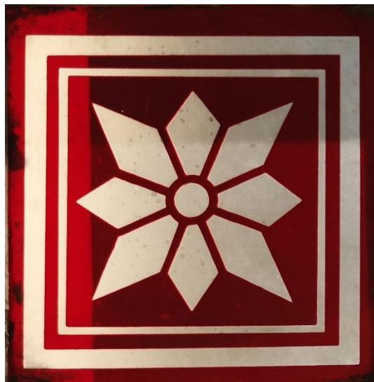
Il. 79. Piaskowana rubinowa rozetka z okna klatki schodowej kamienicy przy ul. Sienkiewicza 22 w Toruniu (Fot. Adam Kaźmierczak).
