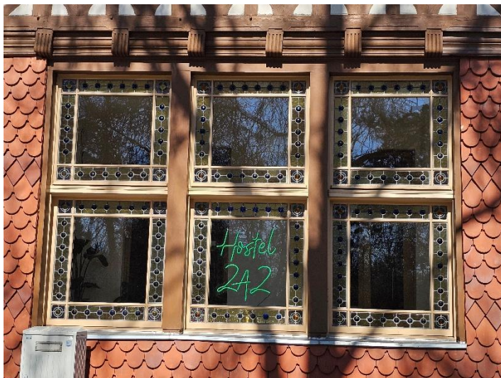
Il. 249. Sposób zamontowania witraży po konserwacji po stronie zewnętrznej na styk z nowym oszkleniem w nowej stolarce okiennej w willi przy ul. Bydgoskiej 50-52 (Fot. Adam Kaźmierczak).
