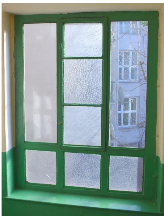
Il. 237. Okno pierwszego półpiętra klatki schodowej w kamienicy przy ul. Poniatowskiego 1 z wtórnie dołożonymi poziomymi szprosami środkowego skrzydła (Fot. Adam Kaźmierczak).
