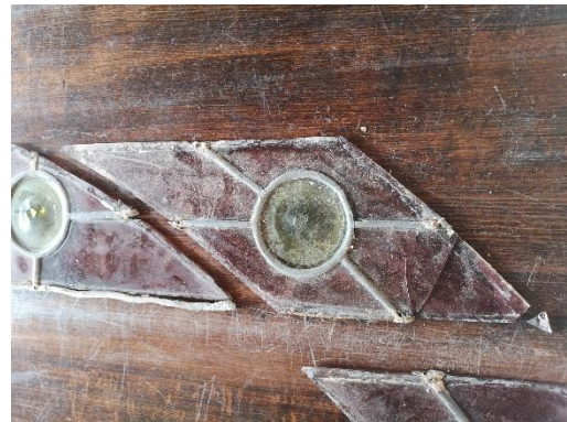
Il. 218. Kwaterki pierwszego i drugiego okna klatki schodowej w kamienicy przy ul. Jagiellończyka 6. Widoczne uszkodzenia i braki listew ołowianych, ubytki szkła oraz zabrudzenia powierzchni (Fot. Adam Kaźmierczak).
