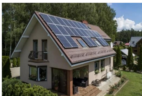
Rysunek 5. Przykład budynku z zamontowaną instalacją fotowoltaiczną w technologii BAPV [24]
