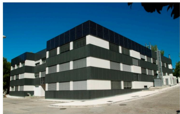
Rysunek 9. Modernizacja obiektu CINEMAT w Hiszpanii z zastosowaniem technologii BIPV: a) przed modernizacją; b) po modernizacji [36]
